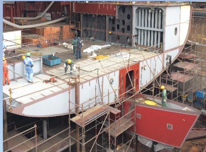
船尾の様子。飛び出している部分の少し後方にアジマススラスター(推進器)が取り付けられる
