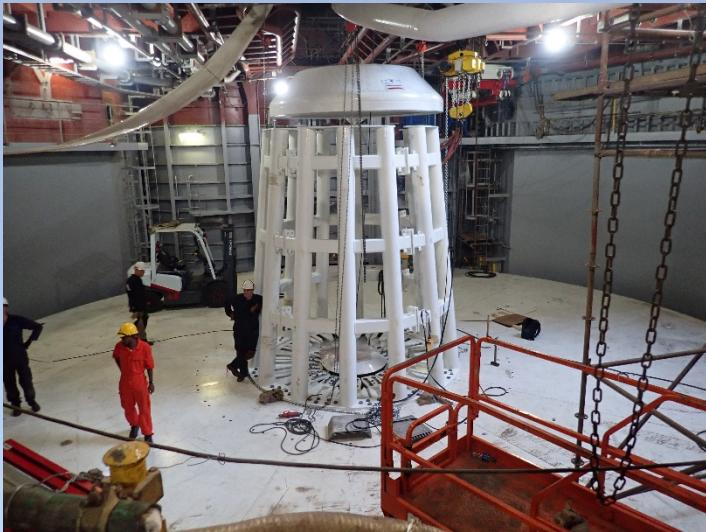
電力・通信ケーブルの搭載が可能なタンク、カルーセルの組み立てが進んでいます。
